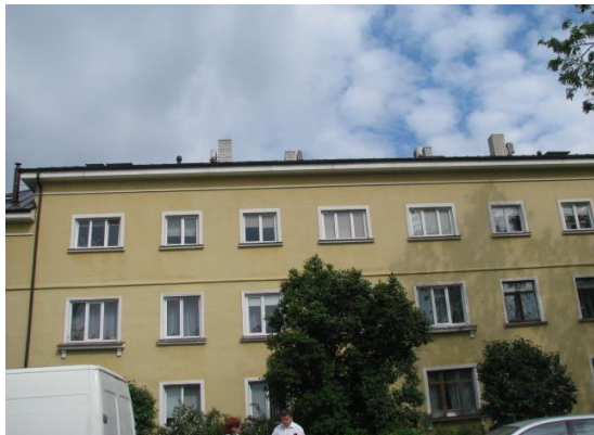
Ліса 3. Фотографії кровлі
