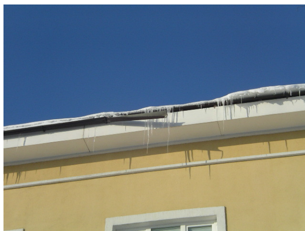
Veerenn katuseserval on lahti läinud ja vajab korrastamist
