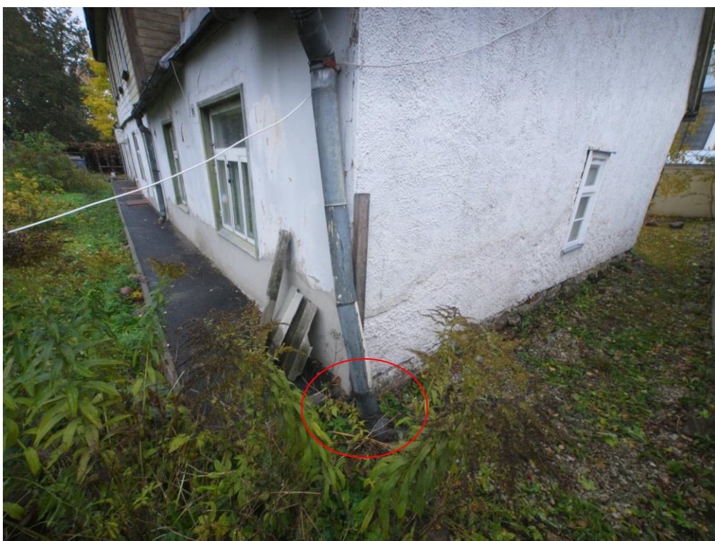
Foto 4. Vaade edelast, suunata vihmaveetoru ots hoonest kaugemale
