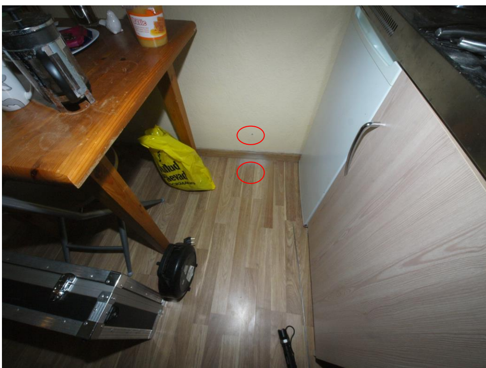
Foto 22. Puuriti augud korter 5 elutoa-magamistoa põrandasse ja seinä, mis osutusid vastavalt betoonpõrandaks ja kiviseinaks
