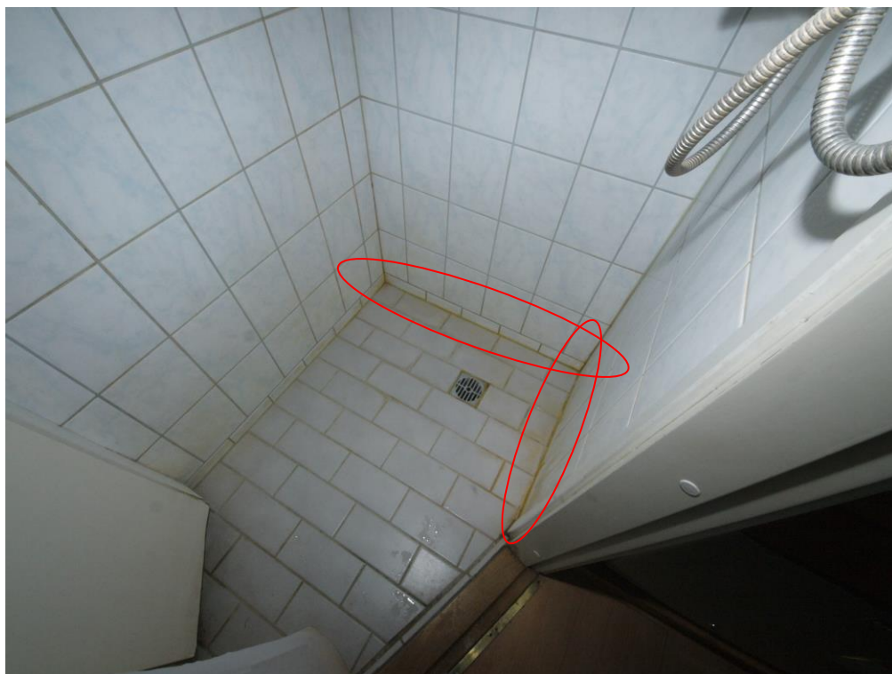
Foto 19. Tähdeldati hallitusseeni korter 3 duširuumi äärtes
