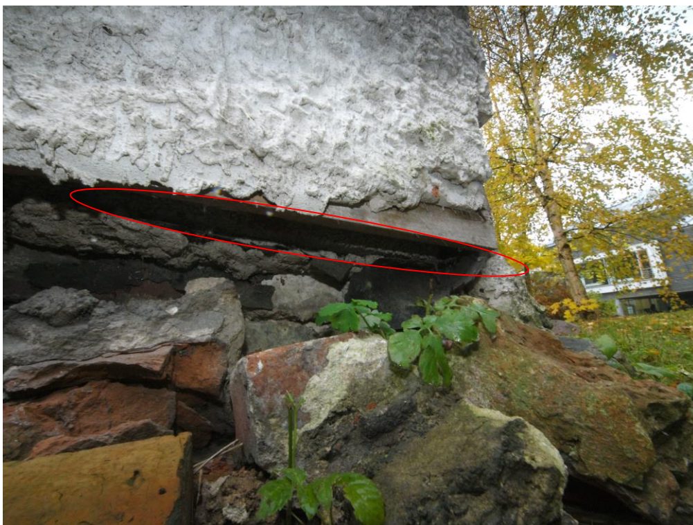
Foto 3. Alumine palgirida on osaliselt väljavahetatud Fibo plokkide vastu
