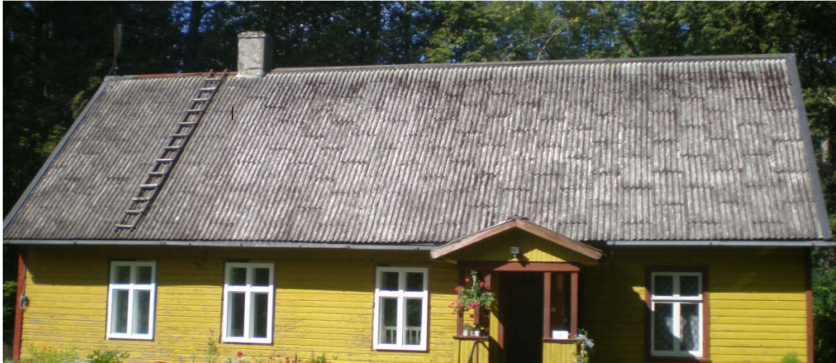
Foto 1. Vaade viilkatusele ja tuulekojale.
