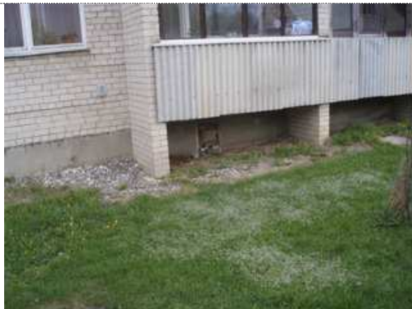
Sillitusriba on kohati lagunenenud. Soovitavalt renoveerida koos sokli soojustamisega
