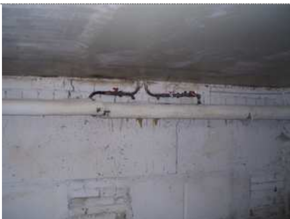
Küttepüstakutel on paigaldatud tasakaaluventiilid
