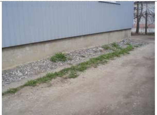
Sillitusriba on kohati lagunenenud. Soovitavalt renoveerida koos sokli soojustamisega
