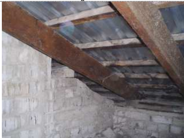
Hoone pööningu ruum. Katusekate ilma kondensaadi tõkke kileta. Vana pööningu soojustus.
