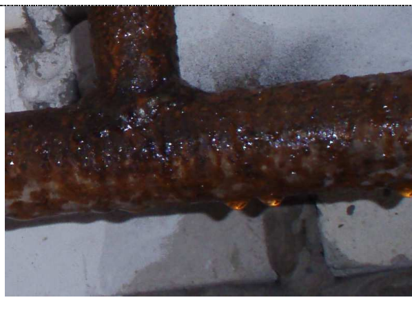
Tarbevee torustik soovitavalt soojustada kondensaadi tekkimise vältimiseks
