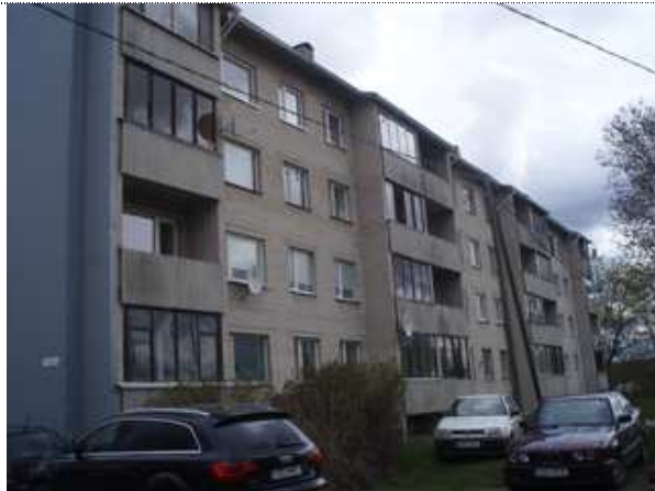
Hoone välisfassaad on soojustamata
