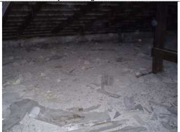
Hoone pööningu ruum. Katusekate ilma kondensaadi tõkke kileta. Vana pööningu soojustus.
