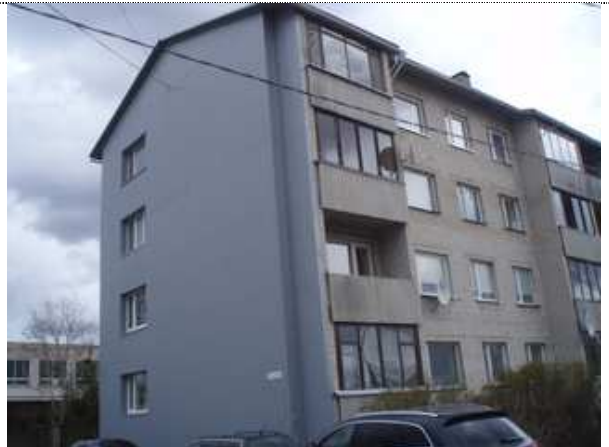
Otsaseinad soojustatud ning kaetud profillplekkiga
