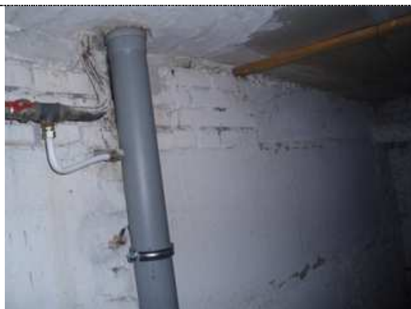
Kanalistaiooni torustik on osaliselt renoveeritud
