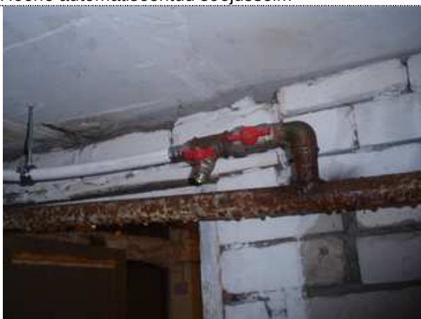
Tarbevee torustik soovitavalt soojustada kondensaadi tekkimise vältimiseks
