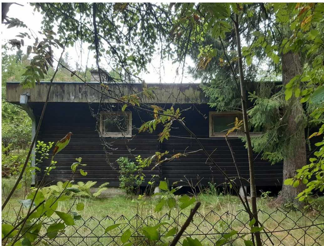
Foto 2: Vaade lammutatavale aiamajale põhjast.
