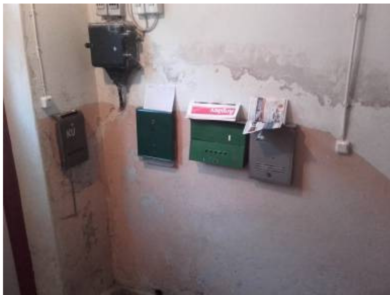
0. Korruse trpikoda – vanad jaotusseadmed demonteeritakse.
