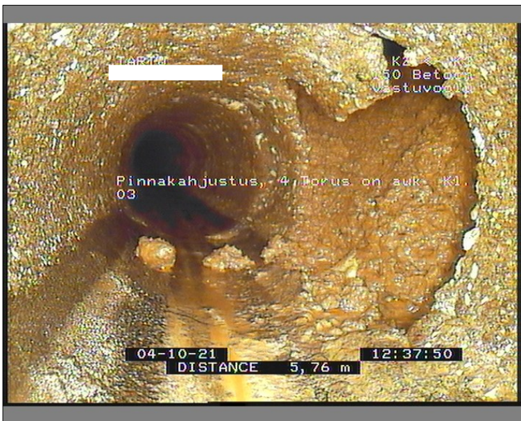
Pilt: K3_K2_1_123920_2_A.JPG, 00:00:47 5,76m, Pinnakahjustus, 4 Torus on auk K1.03
