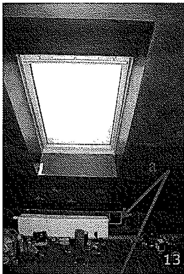
Tarindi avamine eluruumis nr 5. Sarikate vaheline osa on õhukindlalt suletud, millest tingituna puudub katuslaes tuulutus ning mis on põhjustanud hallituse tekke.
