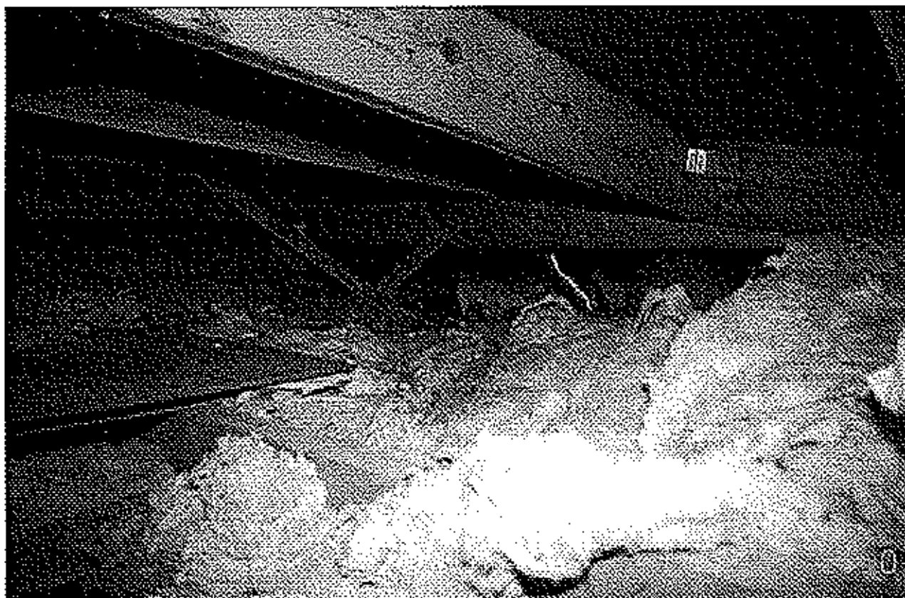
a - sarikate vaheline osa on õhukindlalt suletud, millest tingituna puudub katustlaes tuulutus, niiskus on kondenseerunud aluskattele, vahelae soojustus on märgunud ning tulemuseks on hallituse teke.
