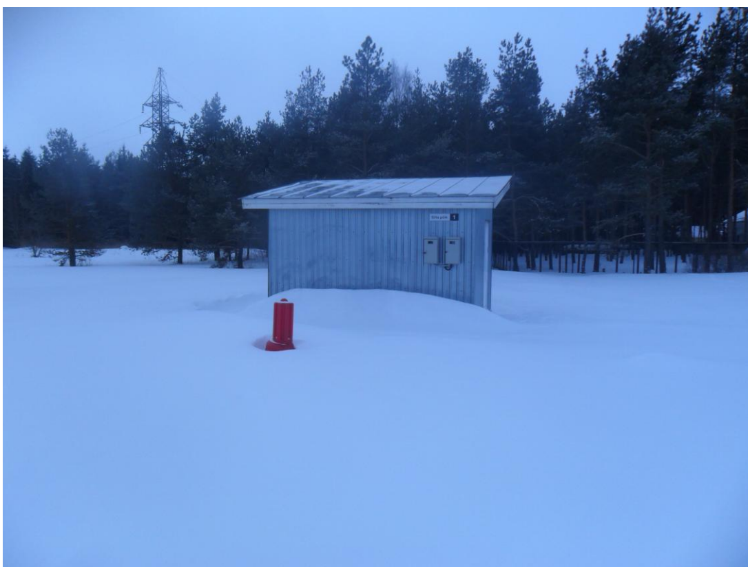
Joonis 1-4 Vaade pumplale põhja poolt Jõelähtme-Kemba maanteelt
