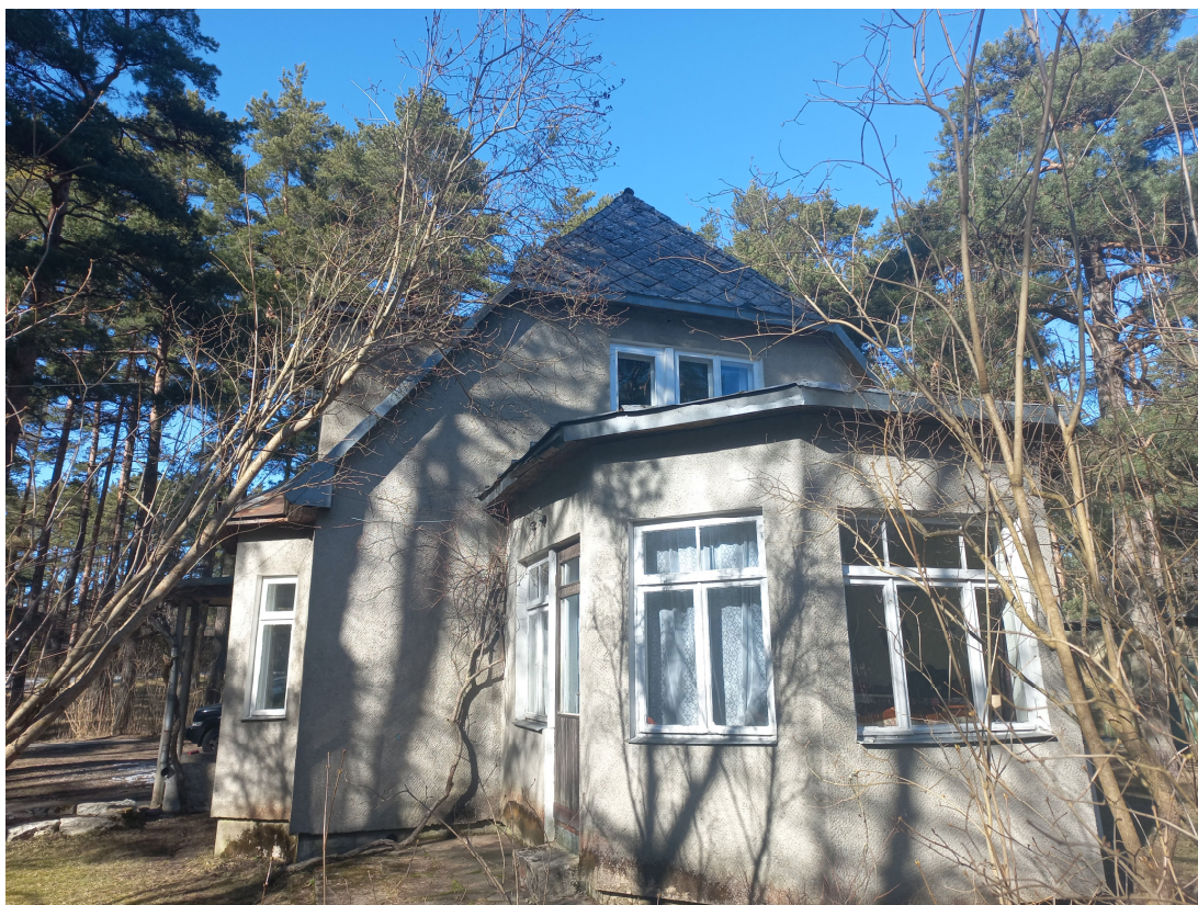
FOTO 2 - Vaade lõunast elamule
