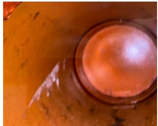
Fotod 2 ja 3. Tänavatorusse suunduva ning kinnistu pool otsakordiga lõppeva toruosa seisukord on hea.
