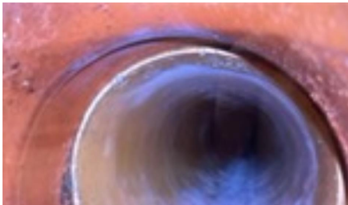
Fotod 2 ja 3. Tänavatorusse suunduva ning kinnistu pool otsakordiga lõppeva toruosa seisukord on hea.
