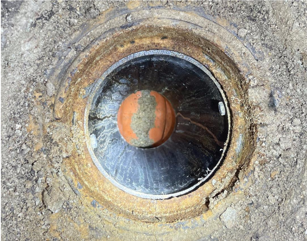
Foto 1. Kontrolltoru kanalisatsiooni liitumispunktis
